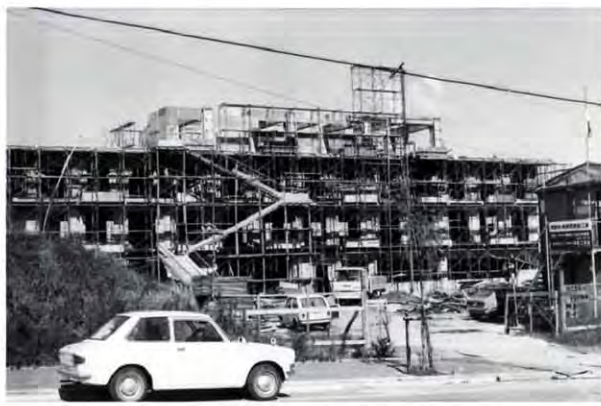
昭和 48 年 建設時写真
